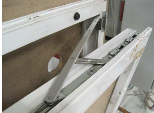
Bild 8 Scherenlager, Ansicht oben
